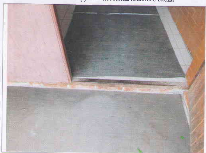
Фото №6 – Наружная входная дверь
