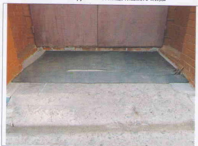
Фото №5 – Входная площадка главного входа
