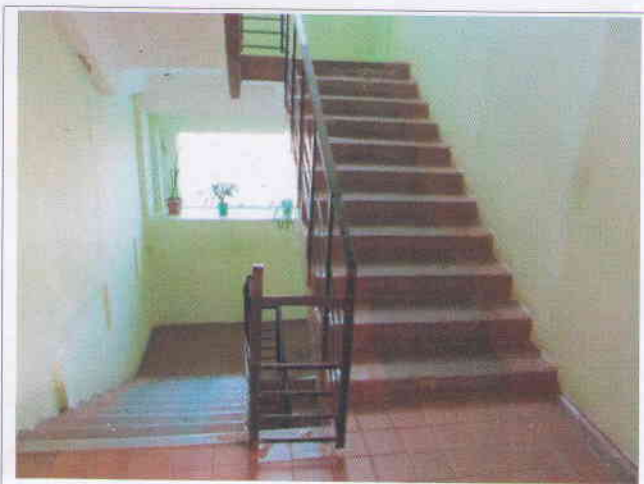
Фото №14 – Внутренние лестницы
