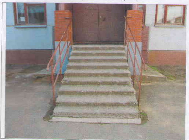
Фото №3 – Наружная лестница главного входа
