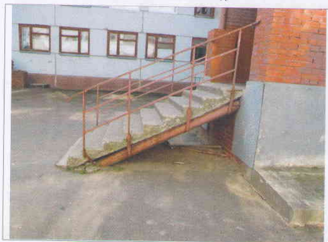
Фото №4 – Наружная лестница главного входа
