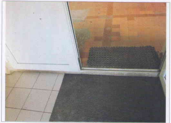
Фото №8 – Внутренняя входная дверь
