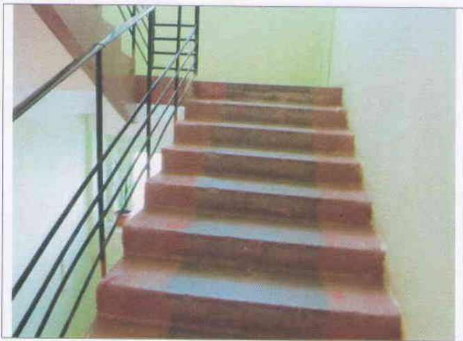
Фото №13 – Внутренние лестницы
