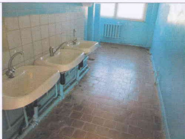
Фото №28 - Санитарно-гигиеническое помещение (раковина)
