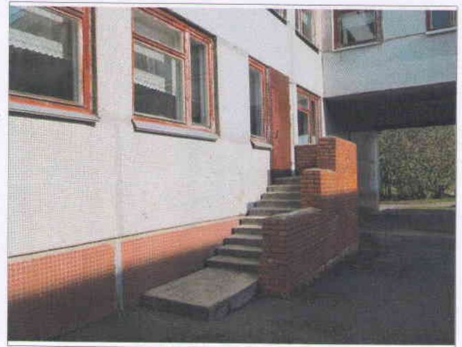
Фото №10 – Запасной выход
