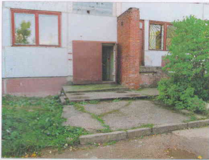
Фото №9 – Запасной выход
